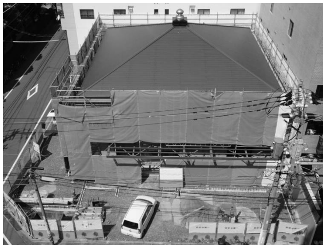
主要部分の工事は終わり、10月から内装工事がはじまります。
